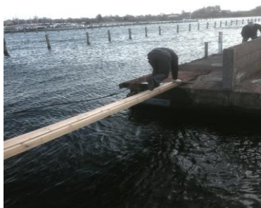
Jeppe Fisker (muligvis!) på vej ud til Bro 5 før overgangen var på plads
